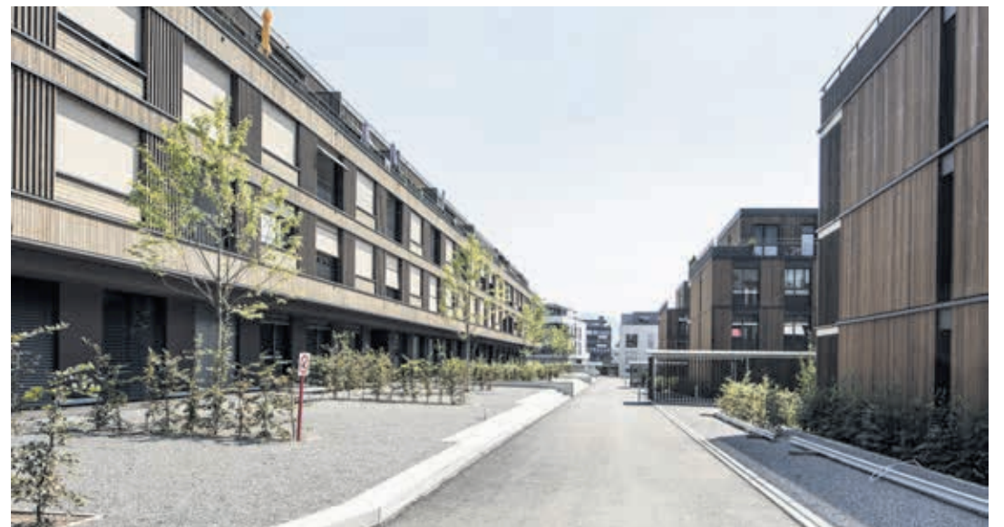
Kombinierter Holzschutz bei Fassade: Überbauung Lorymatte in Münsingen.
