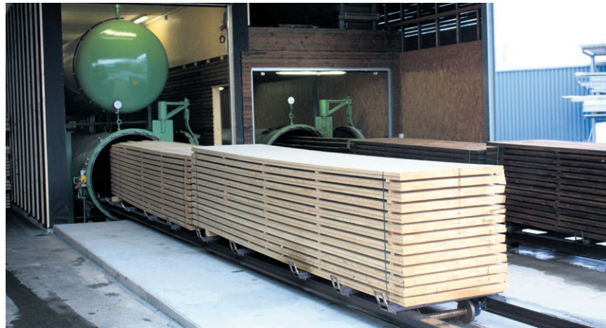
Die neuste Imprägnieranlage der Imprägnierwerk AG. Foto zvg
