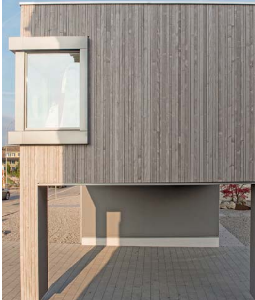
Eine Schmalseite des Gebäudes wurde als Durchfahrt konzipiert.
