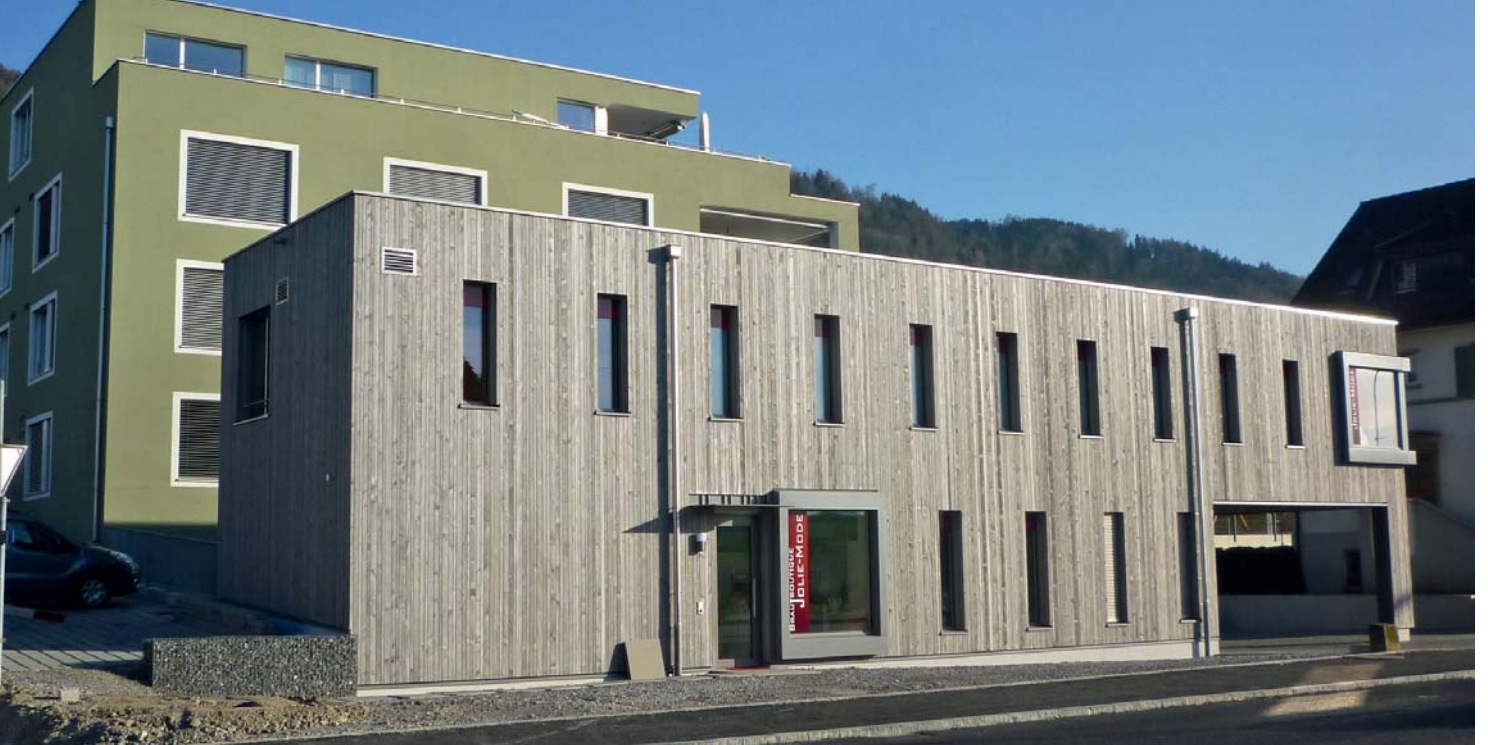
Ein Holzrahmenbau als Gewerbeobjekt in der ersten Reihe der Überbauung «Morgenrot» in Root.
