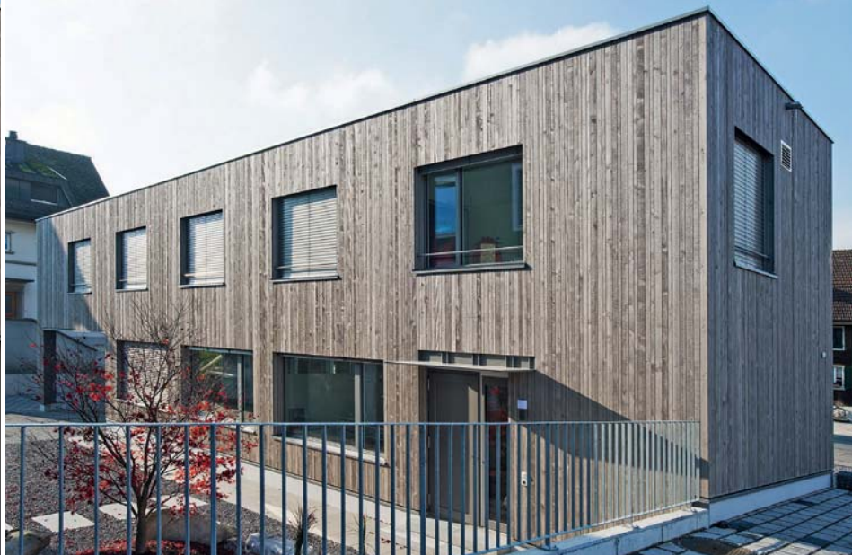
Durchgestylt: Auch die rückwärtige Gebäudepartie kann sich sehen lassen.
