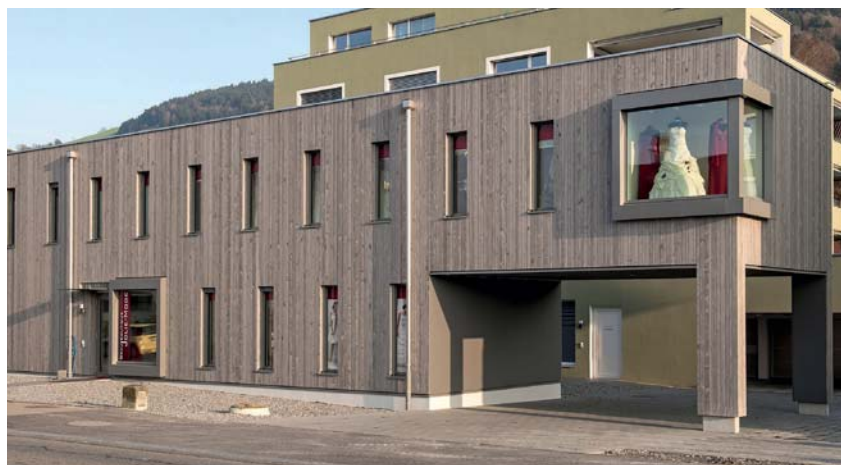
Bei Bauherrschaft und Projektierenden bestand eine Präferenz, das Teilprojekt des Gewerbehbaus in zeitgemässer Holzbauweise zu materialisieren. Ein guter Entscheid – oder?
