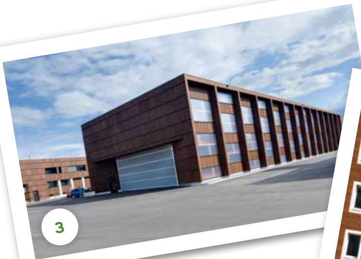
3 Kesseldruckimprägnierung und Holzöl Werkhof ASTRA Sprengi Emmenbrücke (Foto: Kost Holzbau und Gesamtbau)
