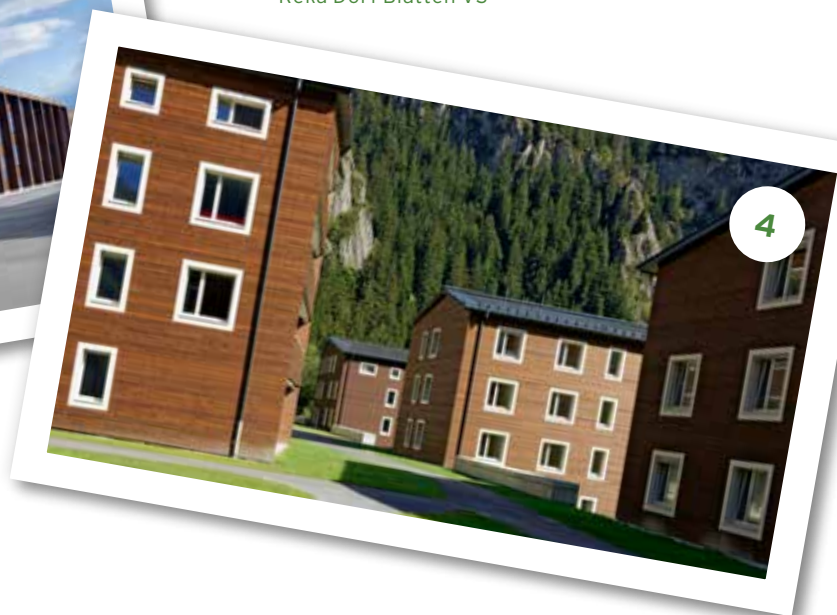
4 Kesseldruckimprägnierung und Holzöl Reka Dorf Blatten VS
