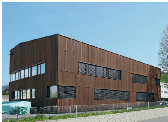
Fassade* nach sechs Jahren.
