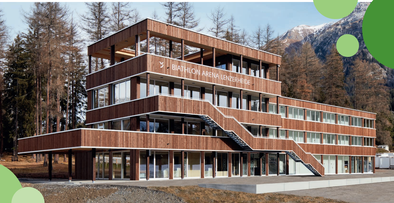
Imprägnierte Fassaden und Terrassenroste der Biathlon Arena Lenzerheide
