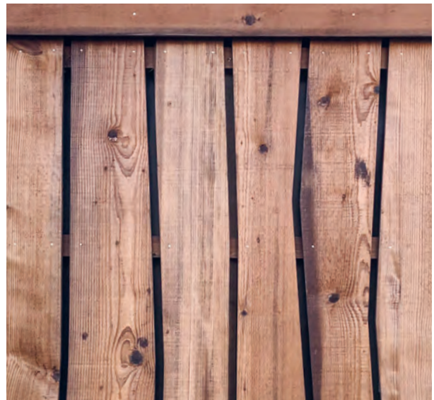
Fassade mit vert. Ausschnitten (KDS Braun & 1x Holzöl)
