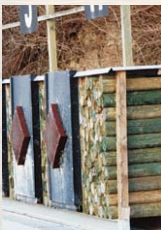
Holzfüllung mit bis zu fünf-fach längerer Lebensdauer dank Druckimprägnierung
