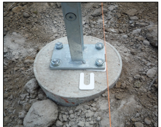
6. aufgeschraubter Fuss m. Unterlage
