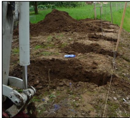
2. Aushub der Fundamente
