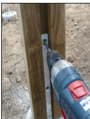
7. Holzpfosten montieren
