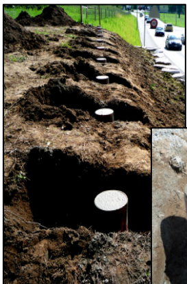
4. fertige Fundamente
