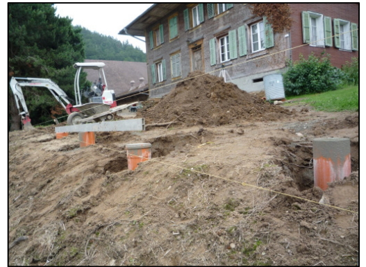
3. Betonfundamente mit PVC Rohren
